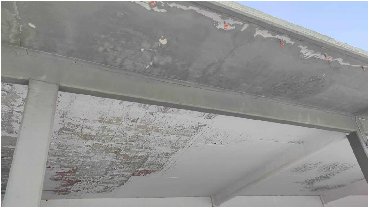
Εικ.2 Τμήμα της οροφής νότιου υπόστεγου
