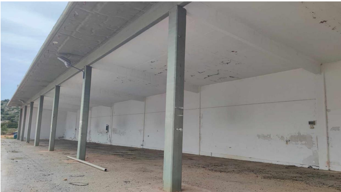
Εικ.1 Υφιστάμενη κατάσταση βόρειου υπόστεγου
